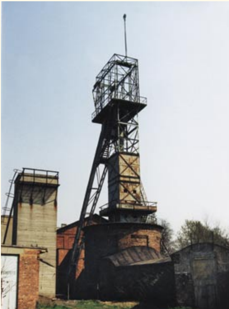
Widok wieży szybowej szybu „Zawada”.
