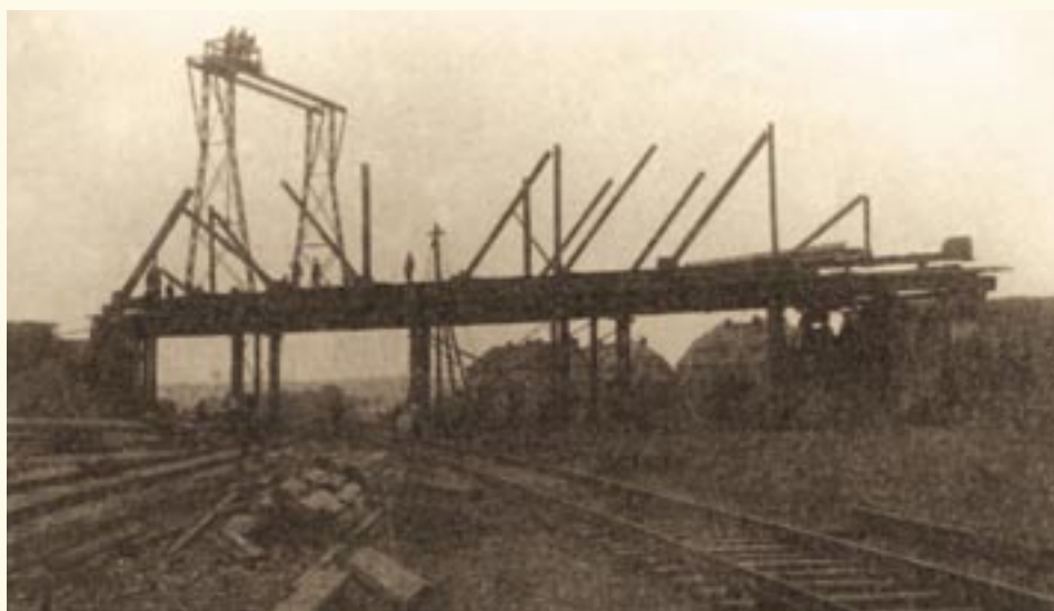
Budowa wiaduktu (zdjęcie z 1916 roku).
