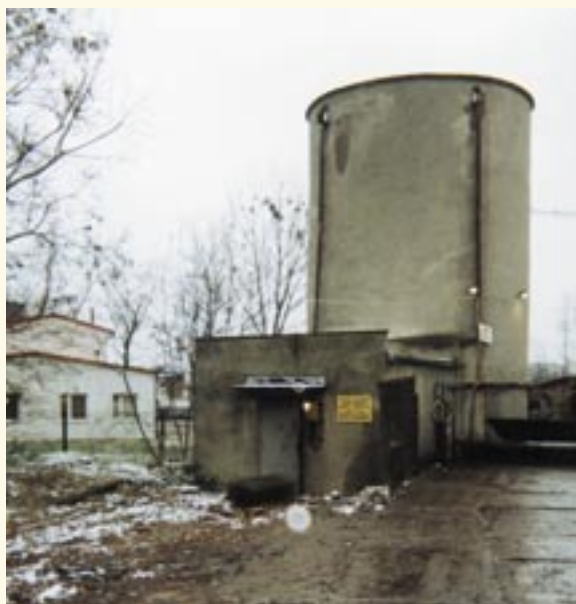
Wieża szybu „Kokoszyce” z budynkiem nadszybia.
