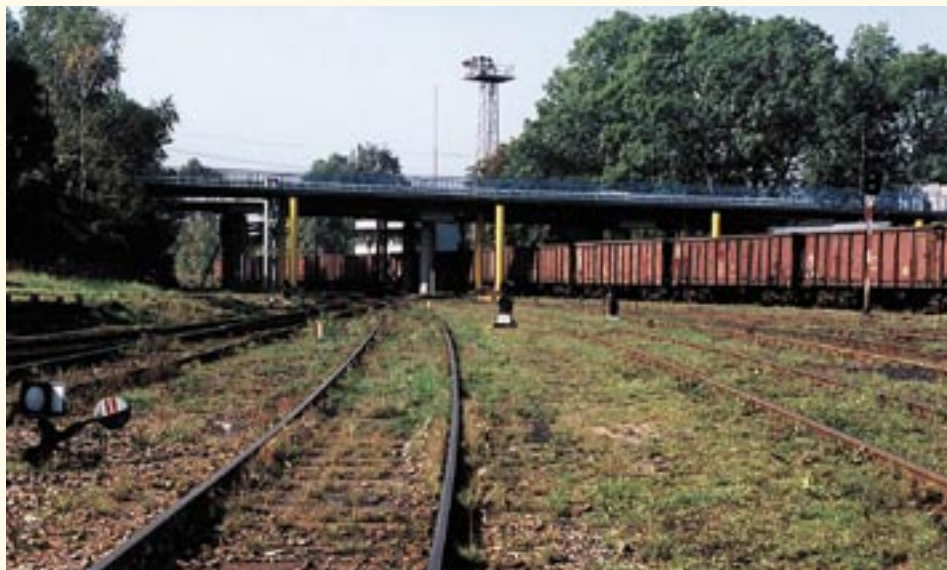
Widok mostu po przebudowie w 2001 roku.
