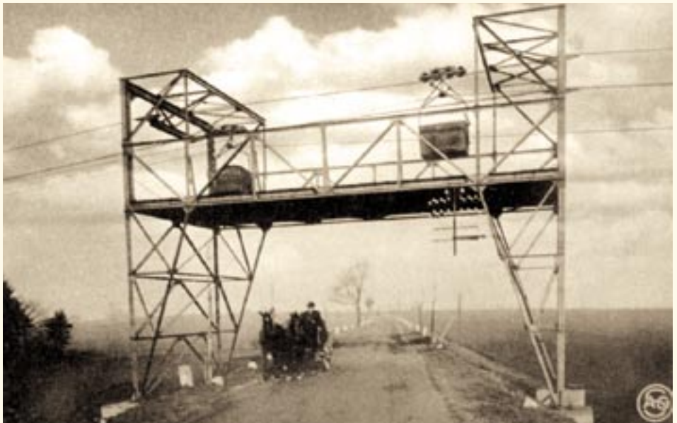
Pomost zabezpieczający przed upadkiem urobku z wagoników kolejki linowej.
