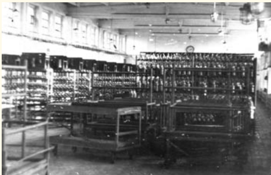
Fragment wnętrza lampowni.
