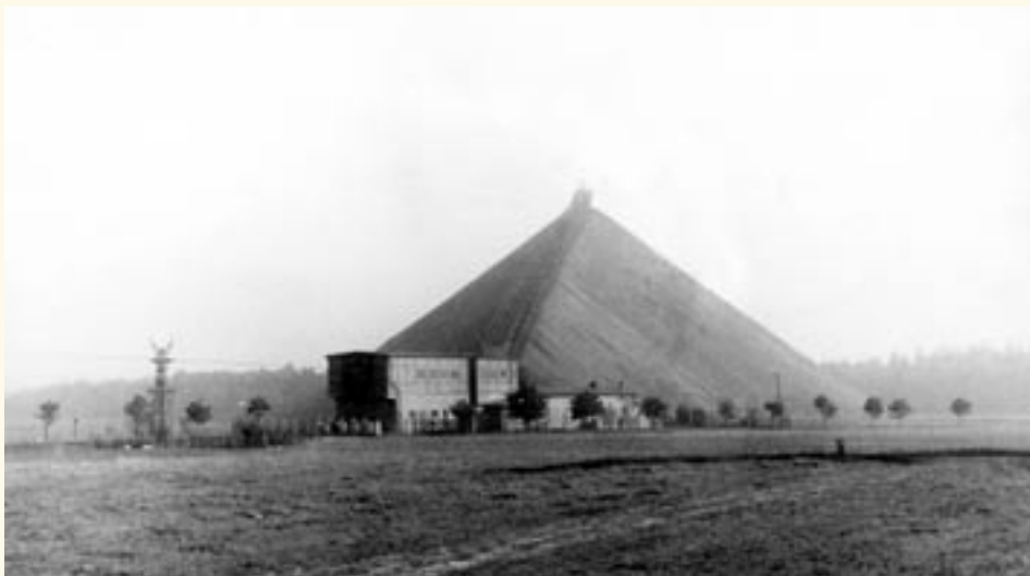
Stacja końcowa kolejki linowej na „Wrzosey” (zdjęcie z 1962 roku).
