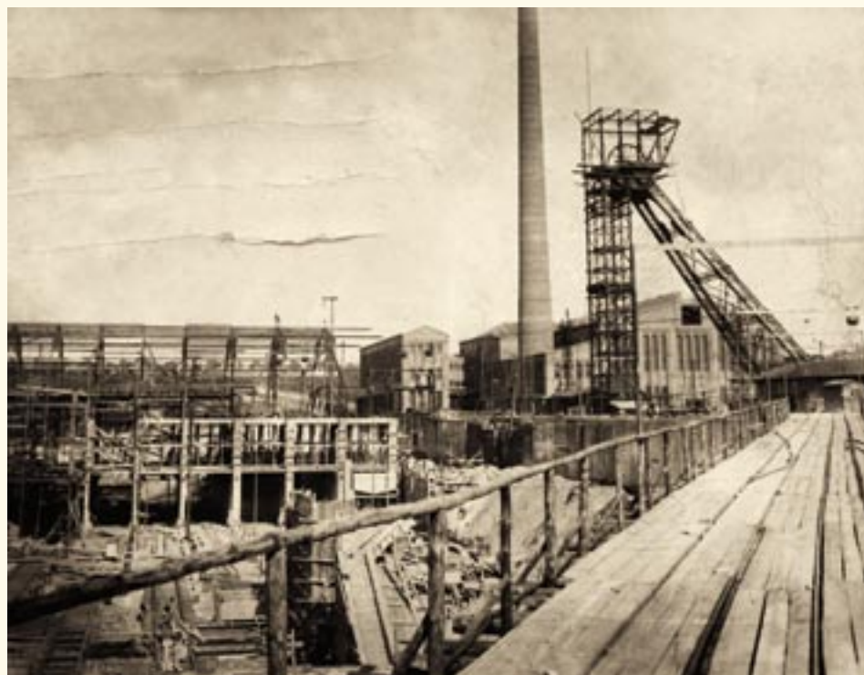
Widok kopalni (szyb Rudolf, rozbudowa Zakładu Przeróbczego) - 1916 rok.
