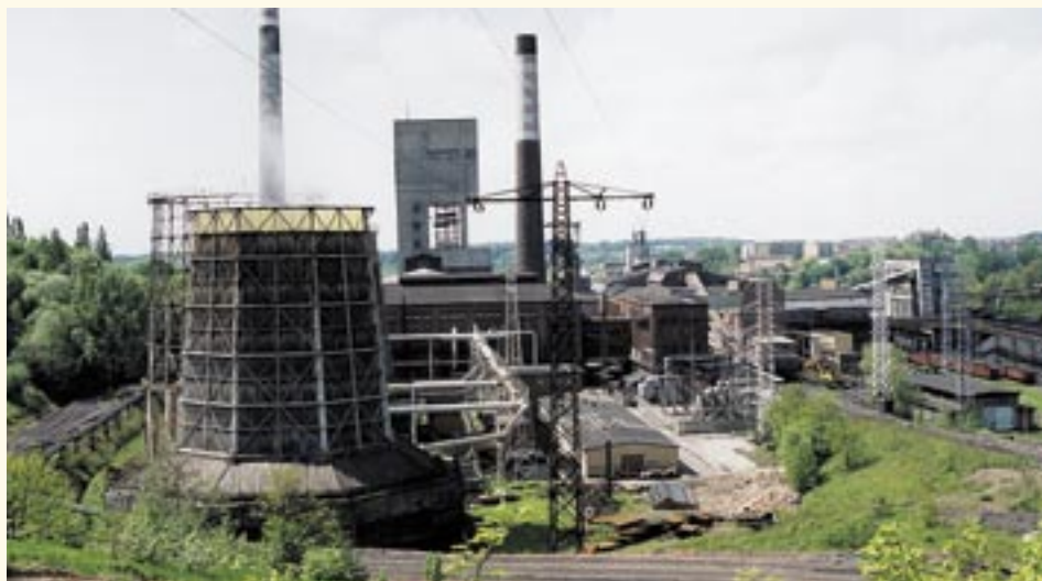
Widok obecny elektrociepłowni.
