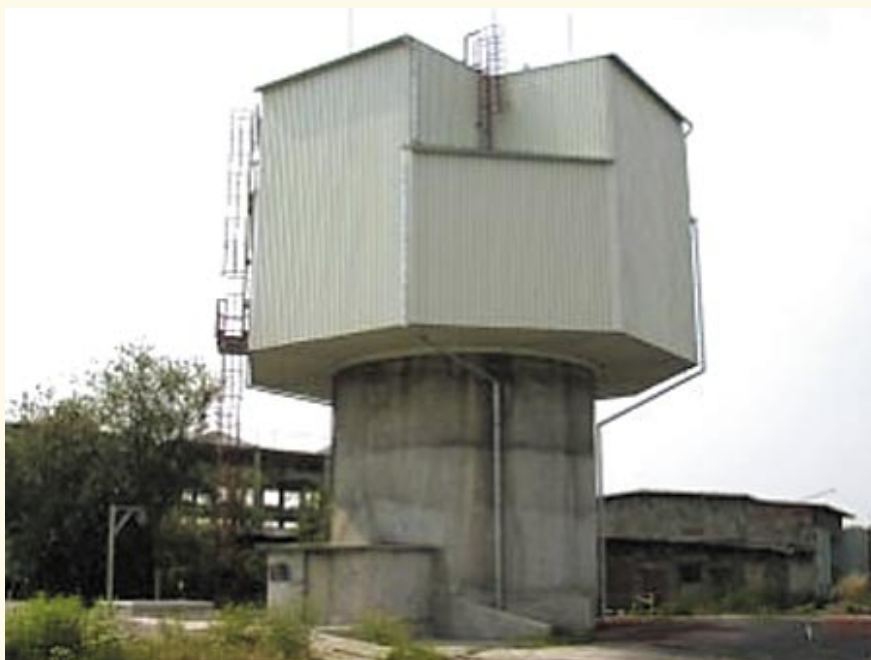
Tłumik wylotu z dyfuzora.
