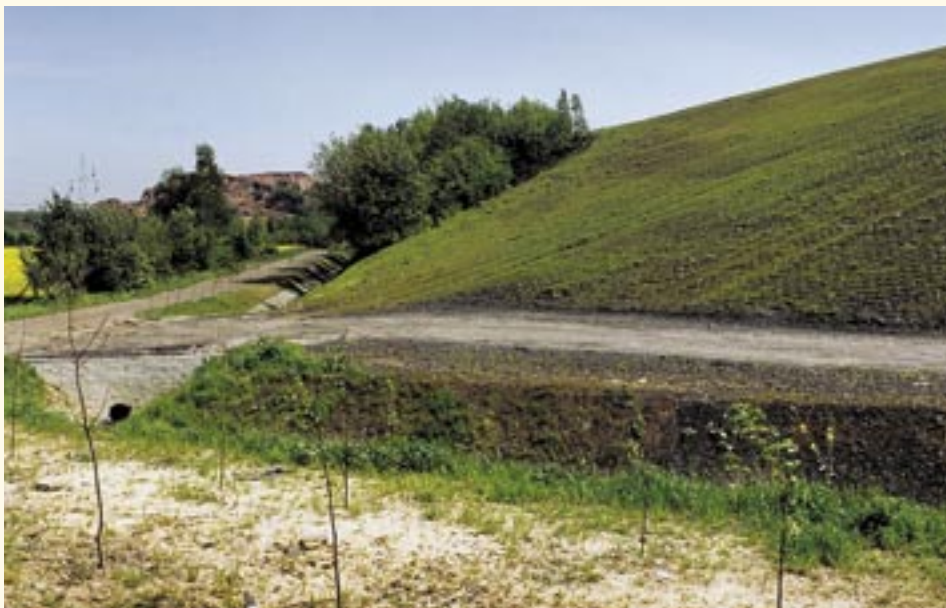
Rekultywacja osadników mułowych. W głębi - zwałowisko „Wrzosa” (zdjęcie z 2001 roku).
