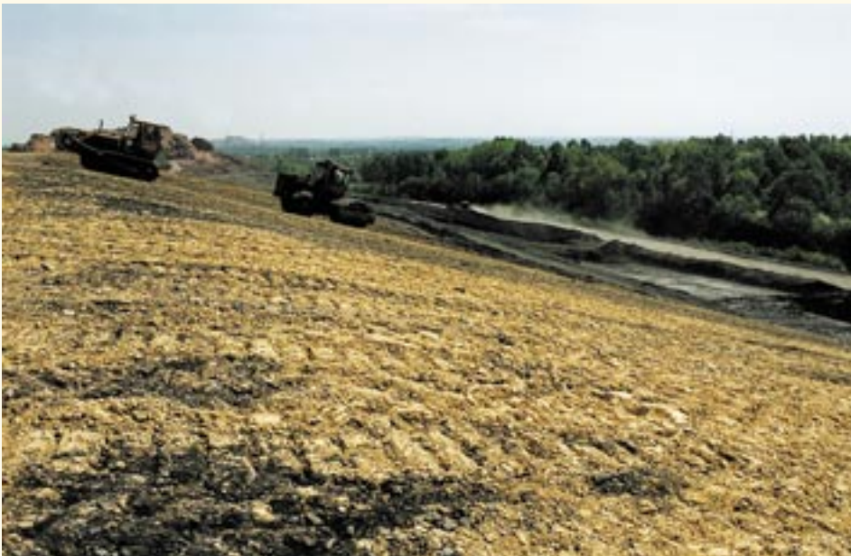
Rekultywacja osadników mułowych. W głębi - zwałowisko „Wrzosa” (zdjęcie z 2000 roku).
