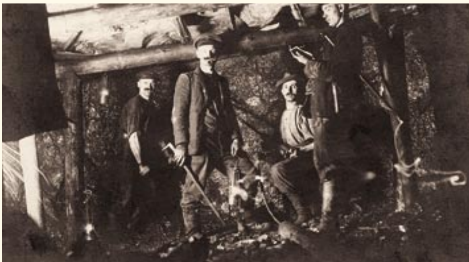
Wyznaczanie kierunku „godzin” w filarze na poziomie 200 m (zdjęcie z 1937 roku).
