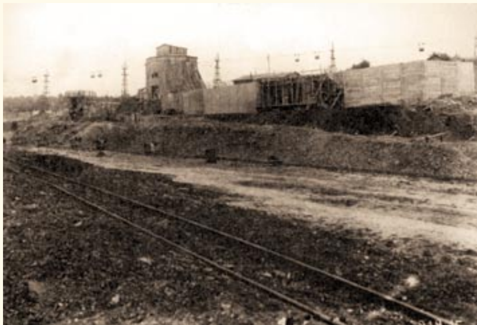
Budowa szybu „Rudolf” - 1915 rok.
